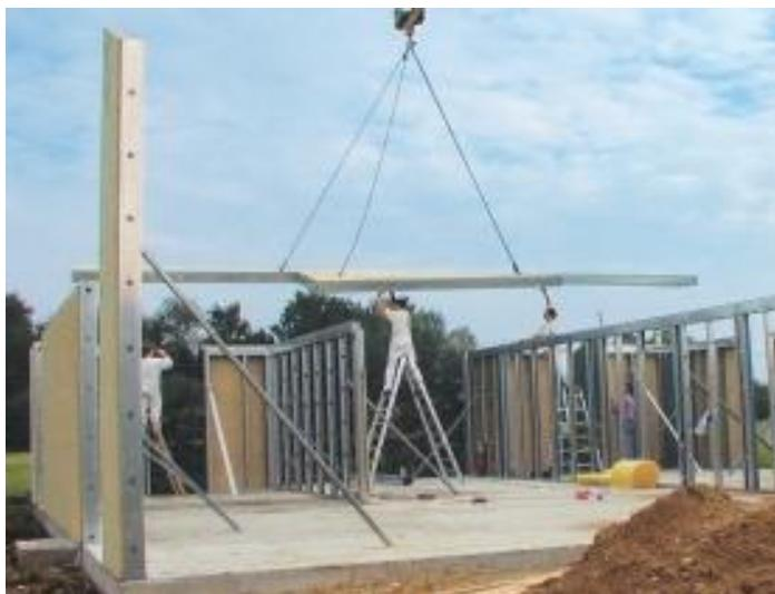
dene Bauteile (z. B. Dachstuhl oder Wandständerwerk) können Grundlage für die Arbeit auf der Baustelle sein. Die Profile werden dem System entsprechend auf der Bodenplatte oder der Kellerdecke aufgebaut. Bei dieser Herstellungsart werden vor Ort keine schweren Hebezeuge benötigt. Da die Verbindungstechniken unkompliziert herzustellen sind, kann der Bau auf diese Weise auch in Eigenarbeit erstellt werden.
