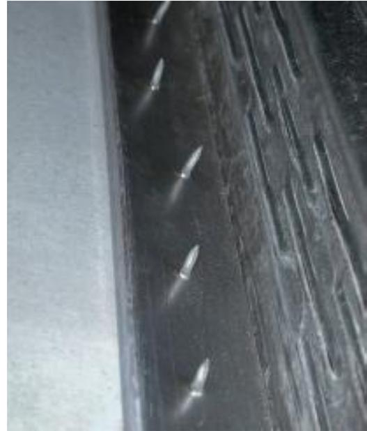
**Abb. 48:** Ballistisches Nageln in Stahlprofile
