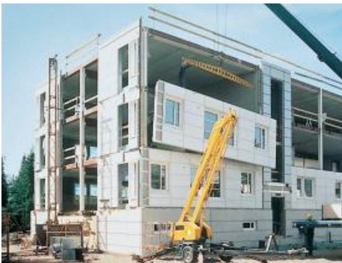
Durch die Vorfertigung ist eine erhebliche Verkürzung der Bauzeit zu erreichen, da das Baugrundstück mit allen Anschlüssen und evtl. auch Außenanlagen fertig gestellt werden kann, während gleichzeitig das Haus produziert wird. Gegenüber der Baustellenfertigung ist der Planungsaufwand höher, und die Entwurfsaufgaben verändern sich.
