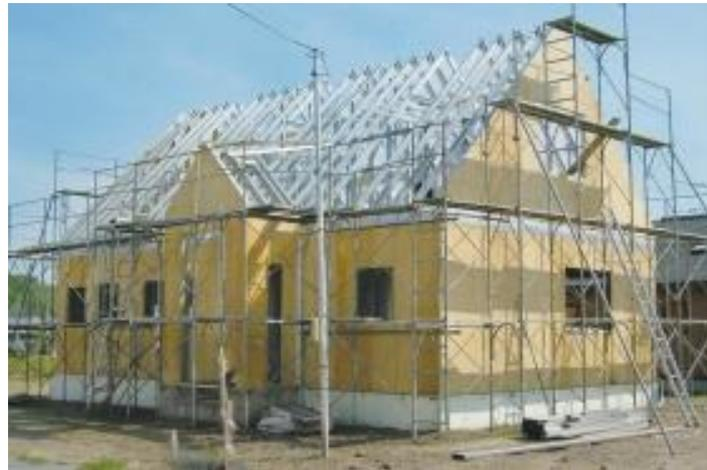
Abb. 17: Gebäude in Stahl-Leichtbauweise (The Japan Iron and Steel Federation, Japan)
