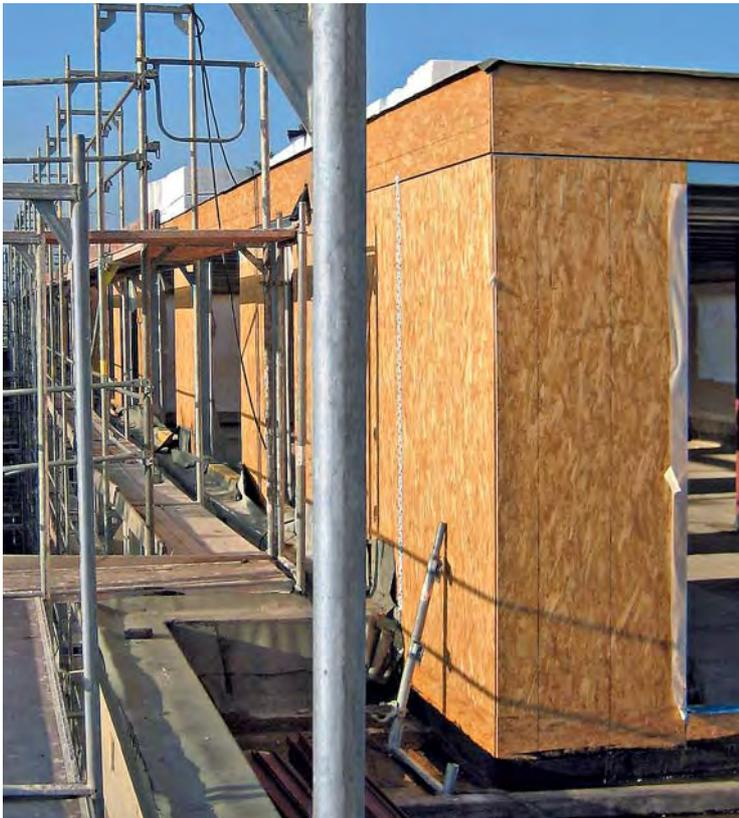
Für die neuen, großflächigen Dachterrassen mussten erhöhte Verkehrslasten nachgewiesen werden, die die vorhandene Dachfläche des Gebäudebestandes nicht aufnehmen konnte. Um die Lasten großflächig zu verteilen und auf die tragenden Außenwände abzuleiten, entschied man sich für einen flächigen Trägerrost aus Stahl-Leichtbauprofilen.
